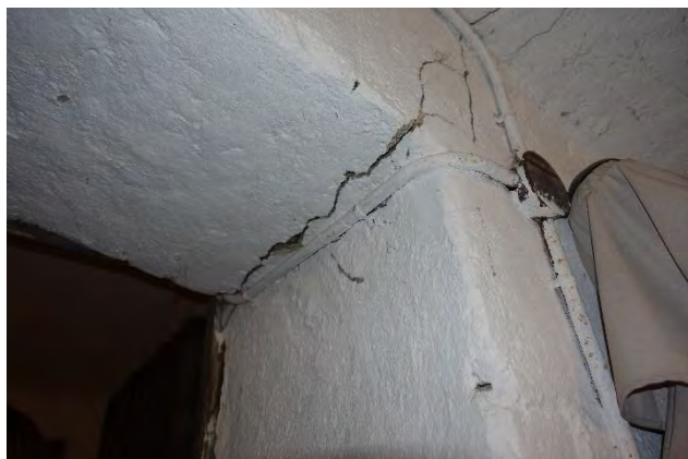
7.2.26 Rissbildung im Auflager (Sturzbereiche) im Keller (exemplarisch)
