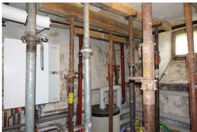
7.2.28 Sicherungsmaßnahmen im Heizungskeller mittels Notabstützung
