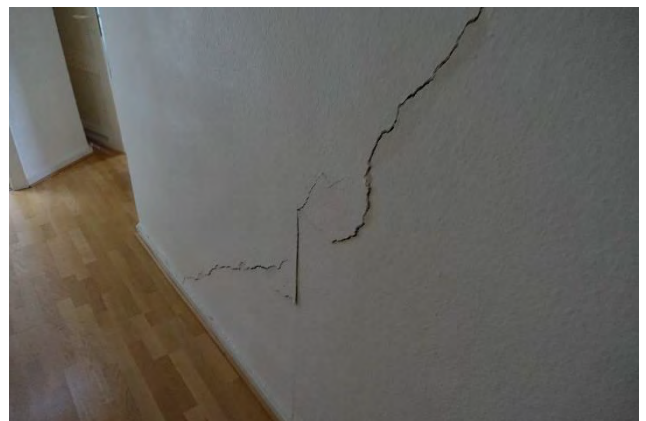
7.2.20 Nördliche Treppenhauswand im 4. Obergeschoss, Rissbildung und Sicherungsmaßnahmen
