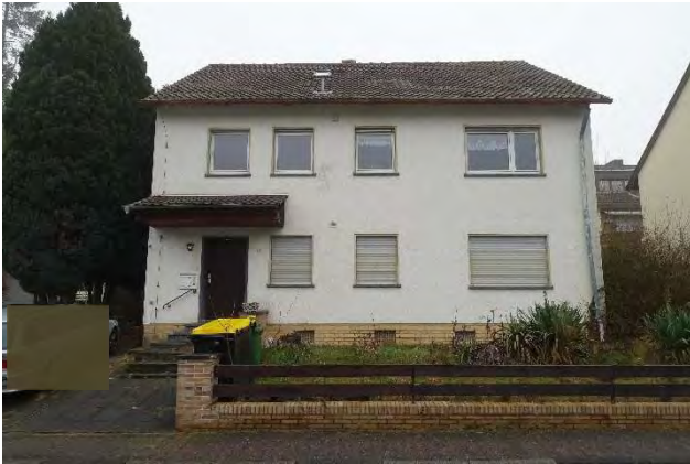
7.3.7 Westfassade, Vorgarten, Blick von der Straße Richtung Osten
