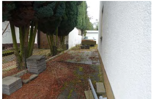
7.3.16 Fahrweg an der nördlichen Grundstücksgrenze, Blick Richtung Osten
