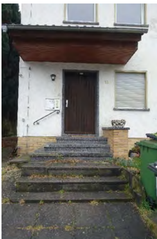
7.3.17 Hauseingang mit Vordach, Blick vom Gehweg Richtung Osten
