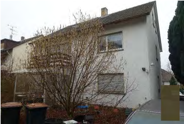
7.3.9 Ost- und Nordfassade, Blick vom Fahrweg zur Garage Richtung Südwesten
