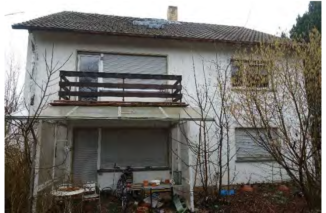
7.3.8 Ostfassade, Blick vom Garten Richtung Westen
