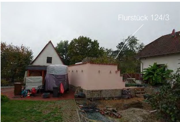
7.3.9 Blick von der Nelkenstraße Richtung Südwesten
