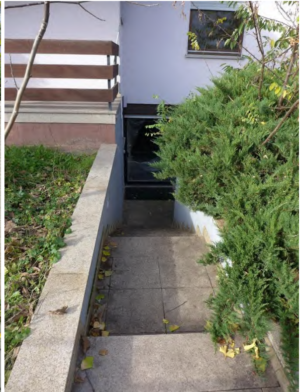
11 b Zugangstreppe Tiefhof
