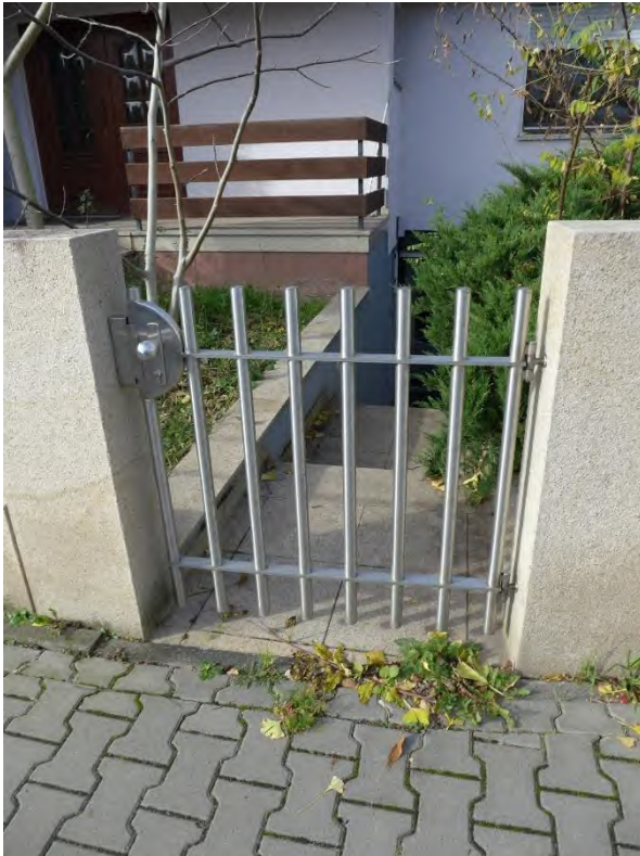
11 a Zugang Tiefhof
