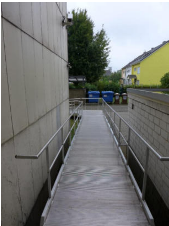
14 a rückseitiger Zugang über Rampe
