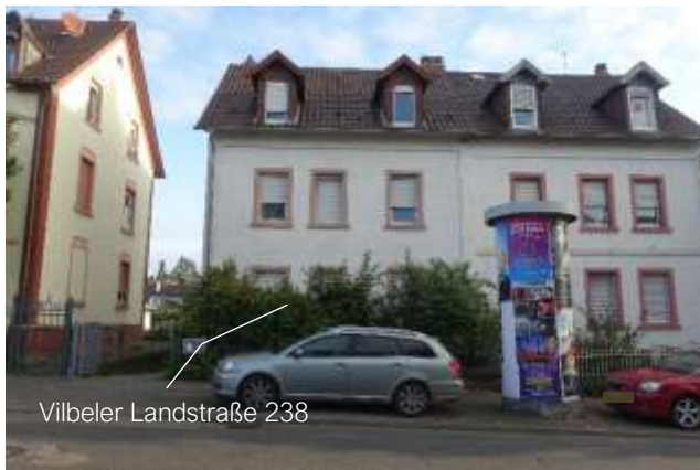
7.2.5 Straßenansicht, Blick von der Straße Richtung Nordosten
