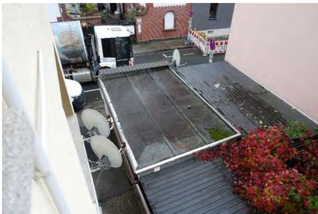
7.2.7 Dachaufsicht Garage/ Abstellschuppen, Weg zum Hauseingang, Blick vom Treppenhaus
