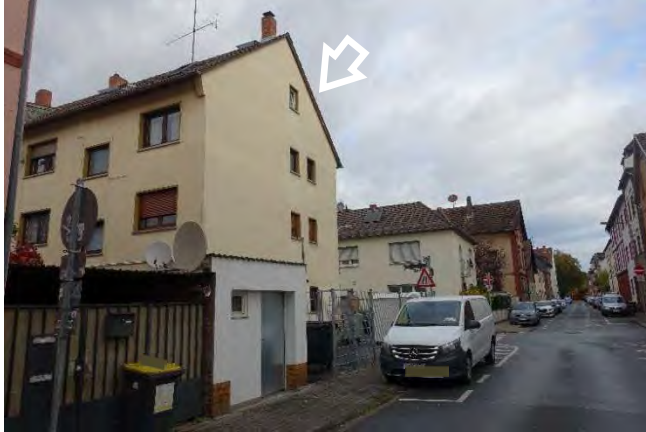
7.2.1 Straßenansicht Süd- und Ostfassade, Blick aus der Straße „Am Brennhaus“ Richtung Norden
