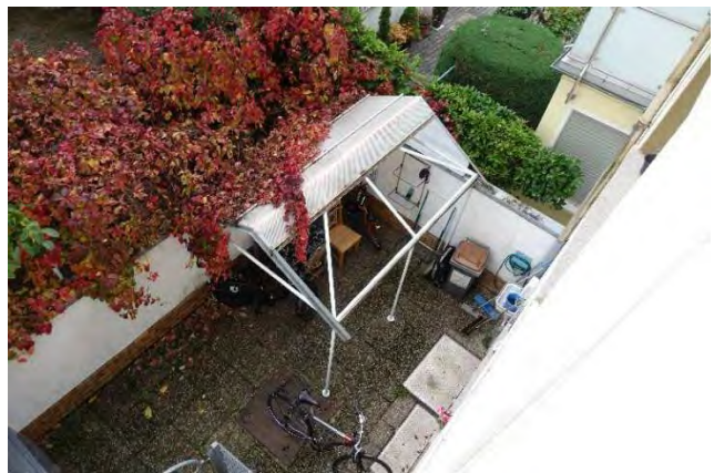
7.2.8 Südlicher Grundstücksbereich vor dem Hauseingang, Blick vom Treppenhaus
