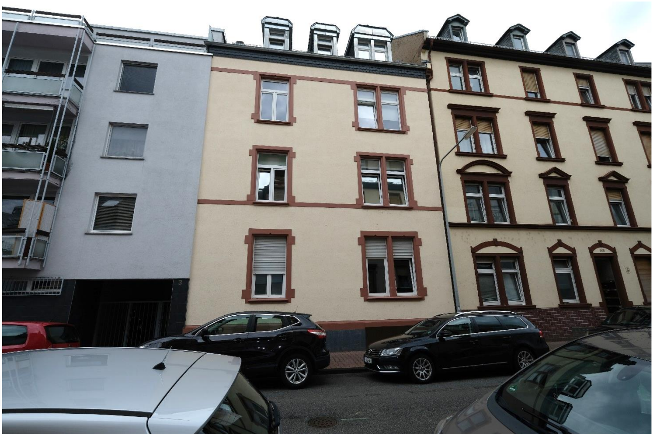
Westfassade zur Odenwaldstraße.
