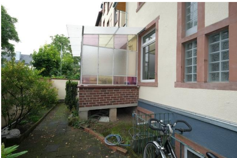
5) Erdgeschoss mit überdachter Terrasse der EG-Wohnung.
