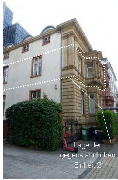
9.4.12 Nord- und Westfassade, Blick vom Gehweg Richtung Südosten
