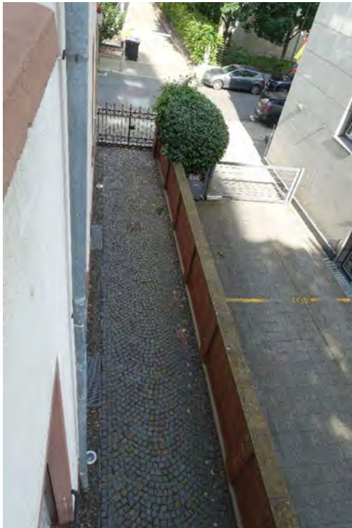
9.4.15 Ein- und Ausfahrt zu den Stellplätzen, Blick von der Einheit Nr. 3 Richtung Straße
