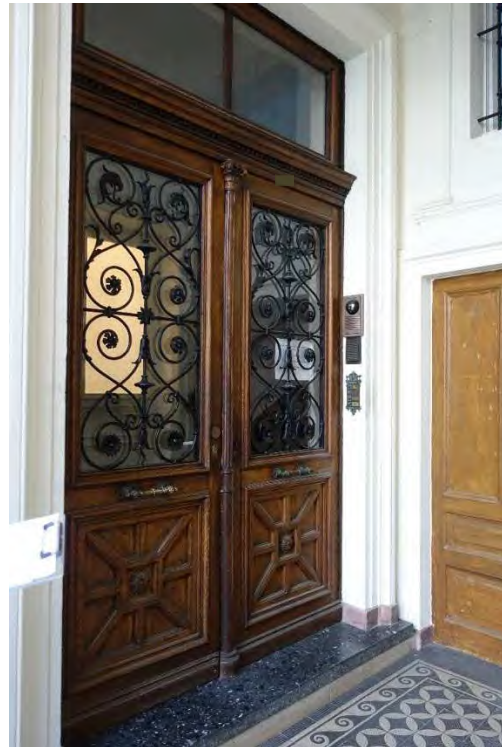
9.4.16 Hauseingang zum Treppenhaus
