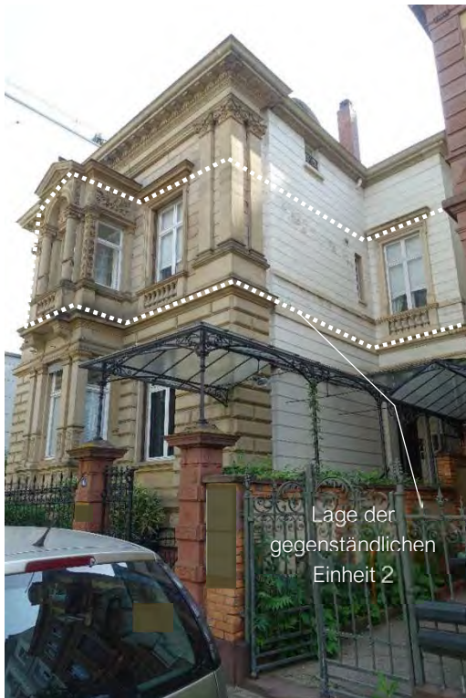
9.4.13 West- und Südfassade, Blick vom Gehweg Richtung Nordosten
