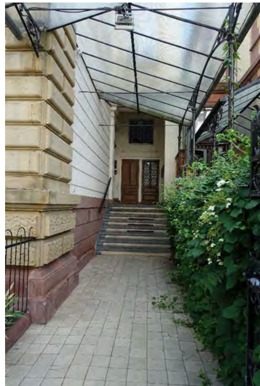
9.4.14 Überdachter Hauseingang, Blick vom Gehweg
