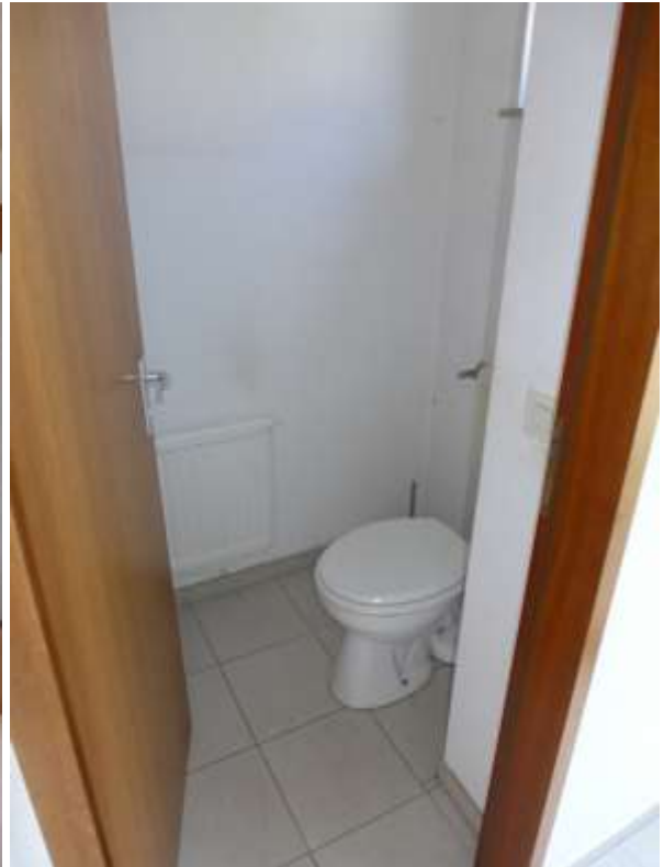
13 b Toilette Erdgeschoss
