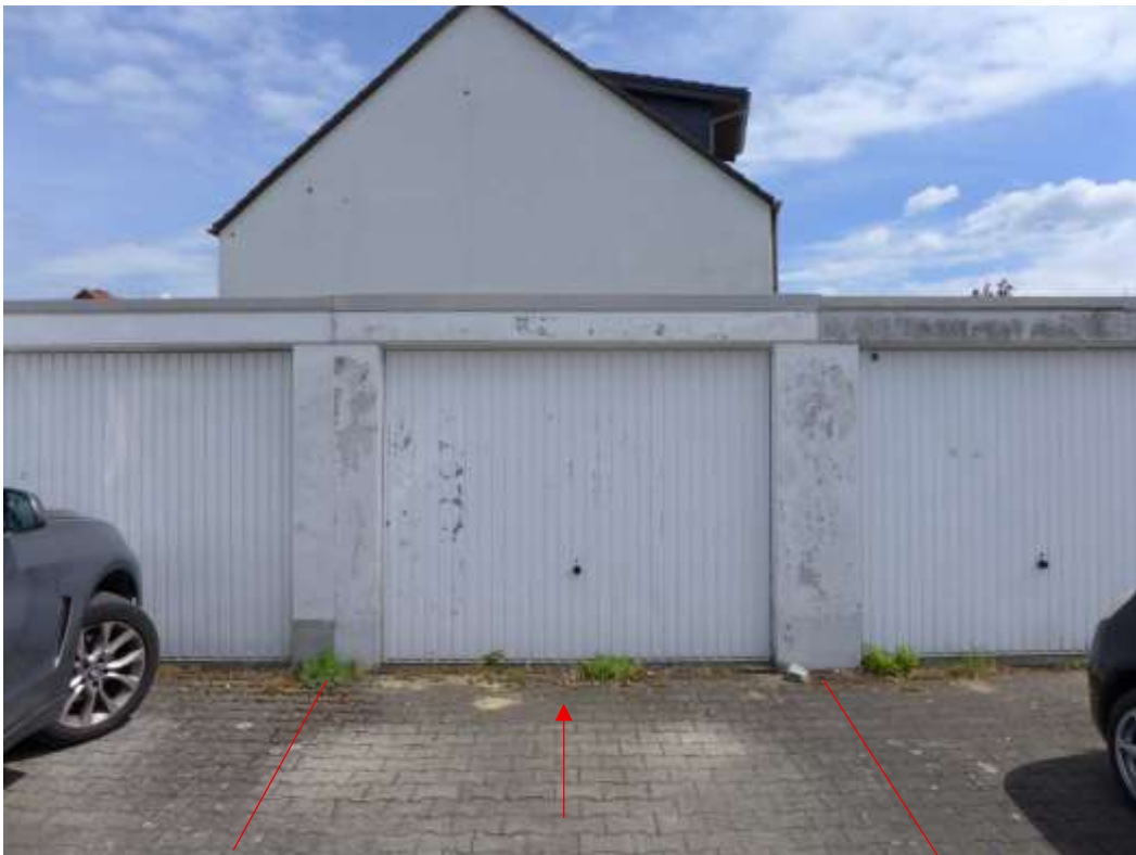
2 Garage auf Flurstück 589 und vorgelagerte Zufahrtsfläche (1/6-Anteil an Flurstück 586/1)
