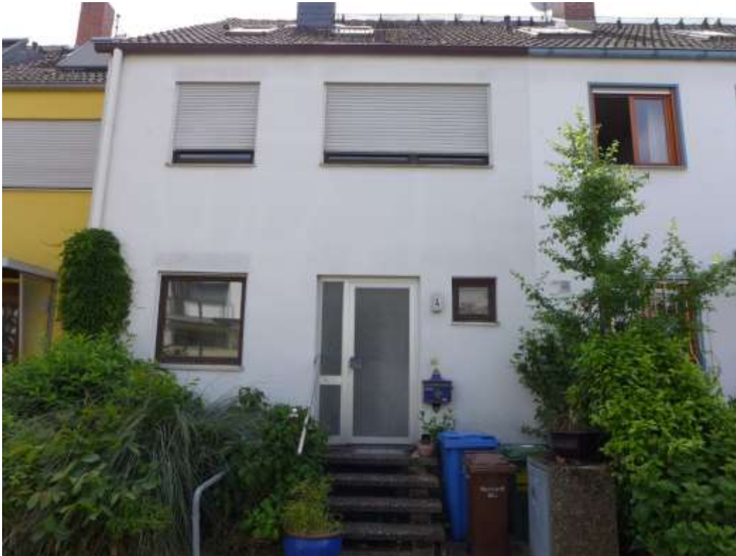
5 Frontansicht vom Hebbelweg, Nordansicht
