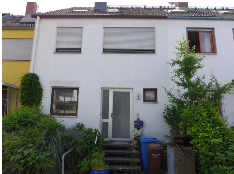
Straßenansicht vom Hebbelweg
