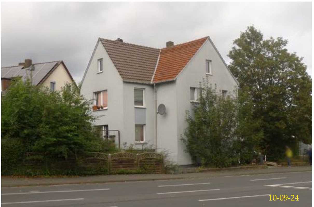
Straßenansicht von Süd-Osten
