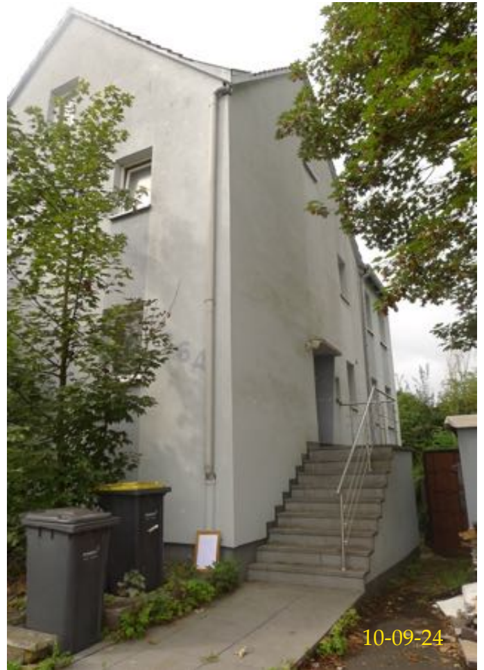
Ansicht Nordgiebel von Nord-Osten
