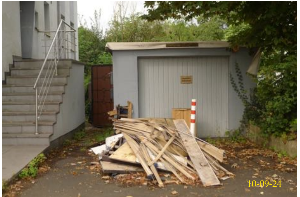
Garagengebäude Ansicht von Osten
