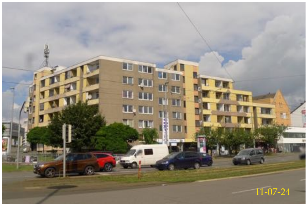
Straßenansicht von Süd-Osten
