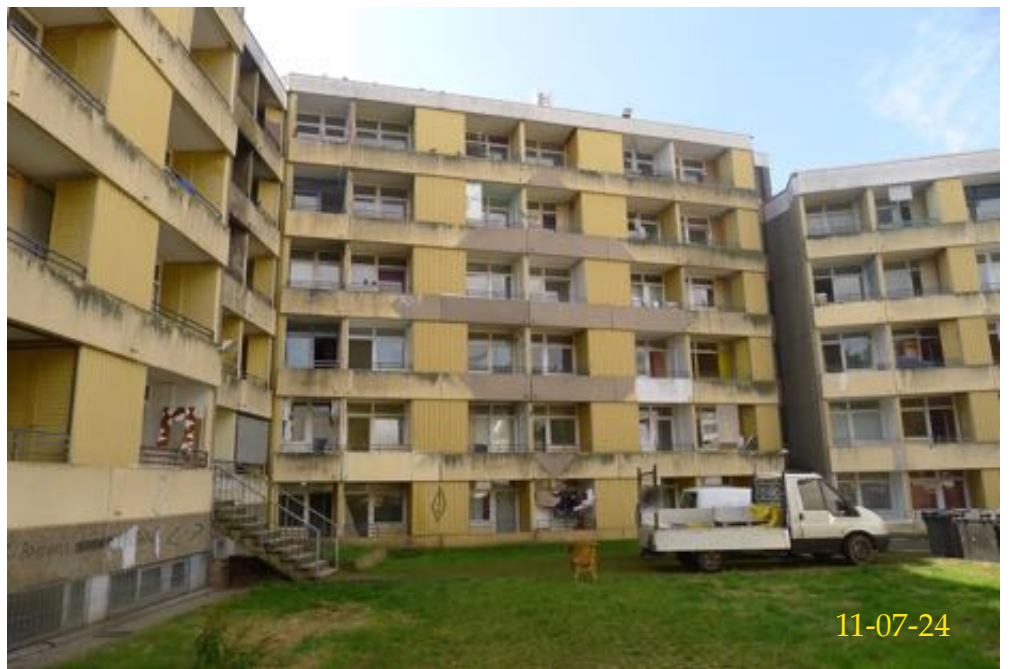
Hofansicht von Norden
