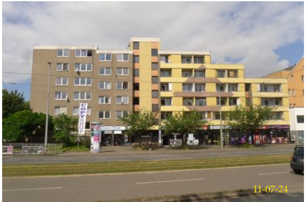
Straßenansicht von Osten
