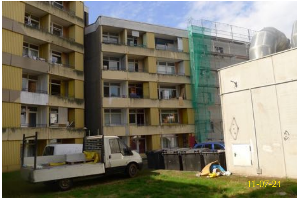
Hofansicht von Norden
