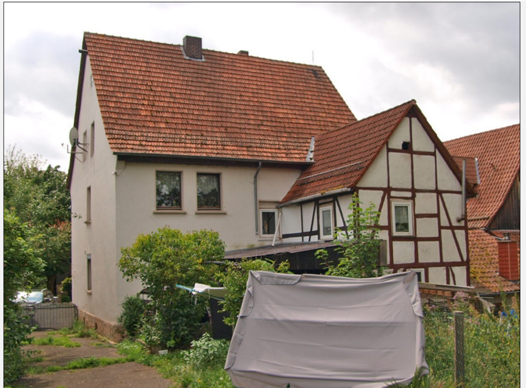
Ansicht des Wohnhauses mit dem Anbau von Nord-Osten
