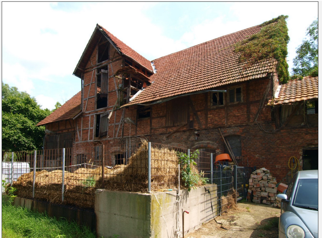
Ansicht Scheune von Nord-Westen
