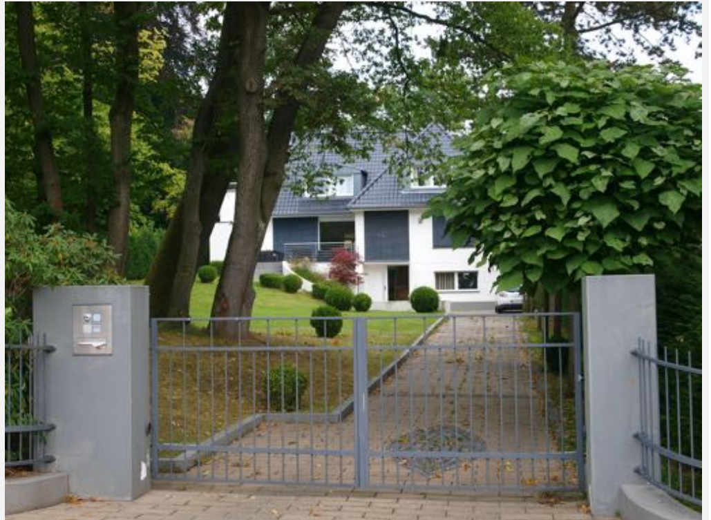
Ansicht des Einfamilienhauses von der Straße „Im Rosental“ (Süden)
