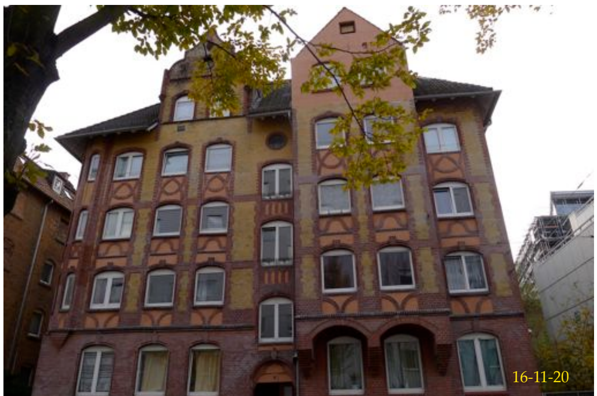
Straßenansicht von Nordosten
