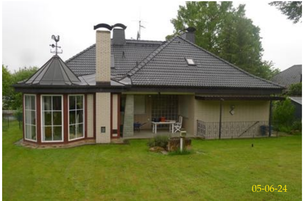
Gartenansicht von Nord-Osten
