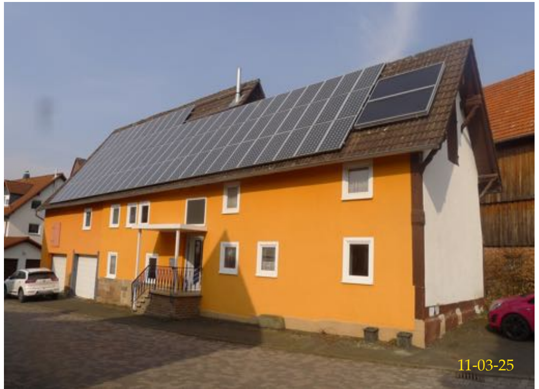
Straßenansicht von Süd-Osten
