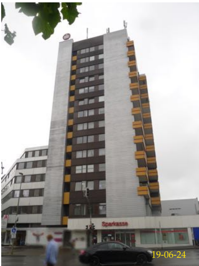
Straßenansicht von Norden
