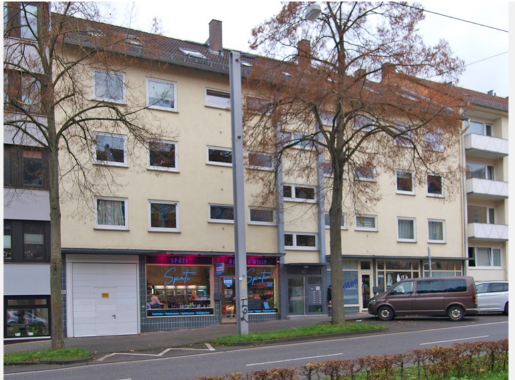
Ansicht des Wohn- und Geschäftshauses von der Wilhelmshöher Allee (Nord-Osten); die zu bewertende Wohnung W 4 befindet sich im 1. Obergeschoss rechts
