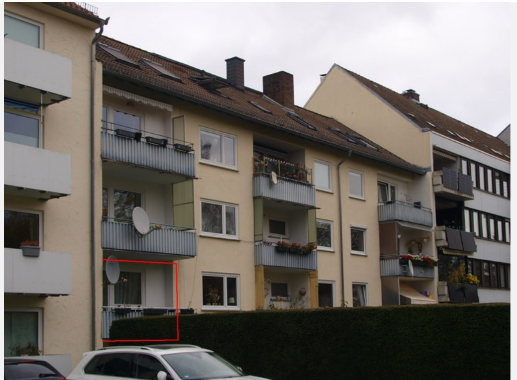
Ansicht des Wohn- und Geschäftshauses vom Hinterhof des Nachbargrundstücks (Süd-Westen); die zu bewertende Wohnung W 4 befindet sich im 1. Obergeschoss
