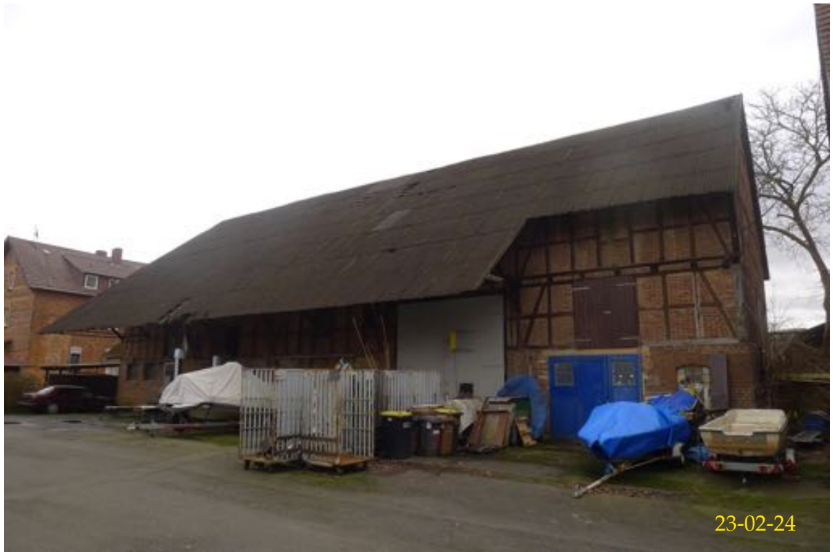
Scheune Ansicht von Norden
