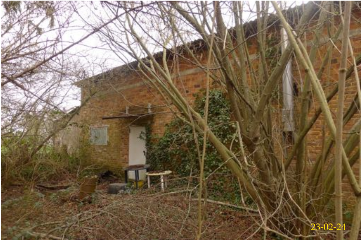
Werkstattgebäude Ansicht von Westen
