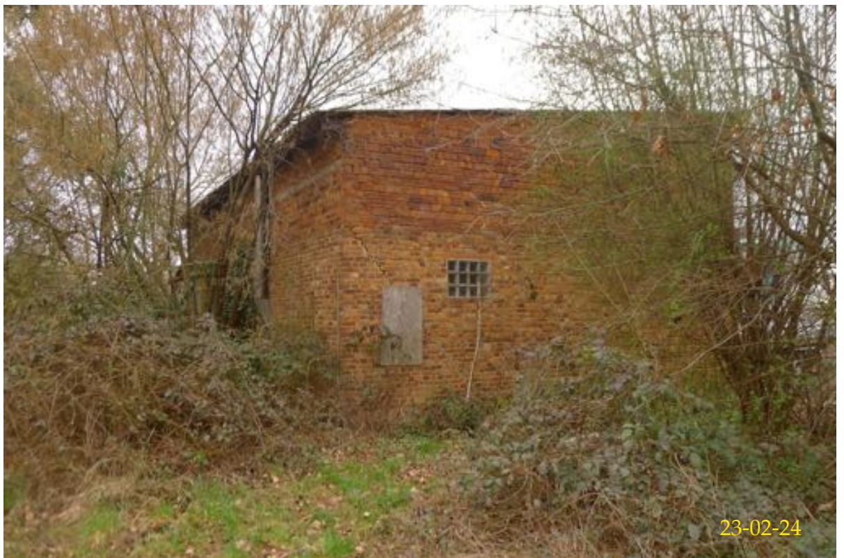
Werkstattgebäude von Ansicht von Süden
