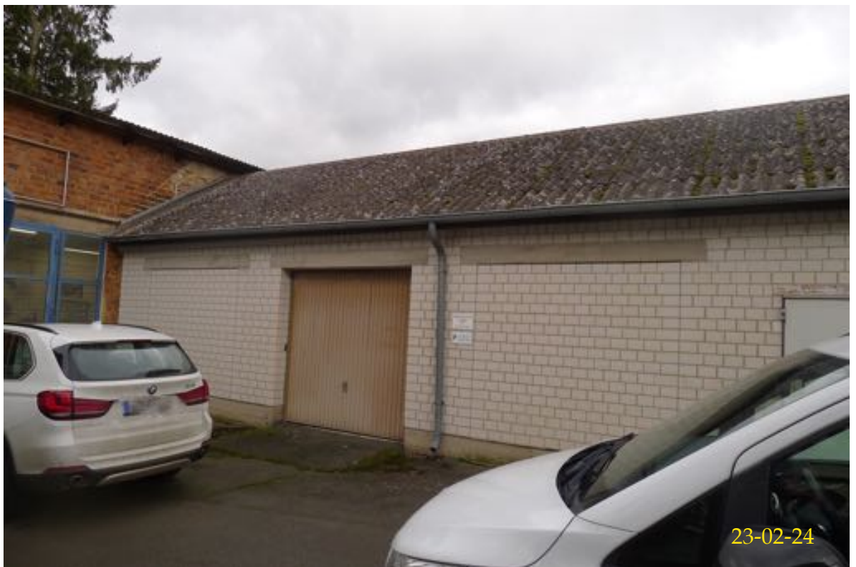
Seitenflügel Fassade von Süden
