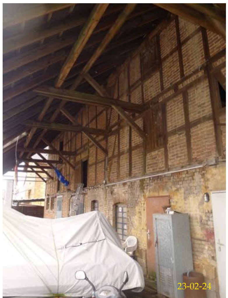
Scheune Fassade Nordseite
