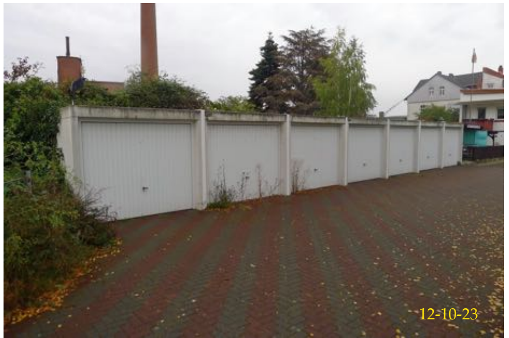
Garagengebäude Ansicht von Süden
