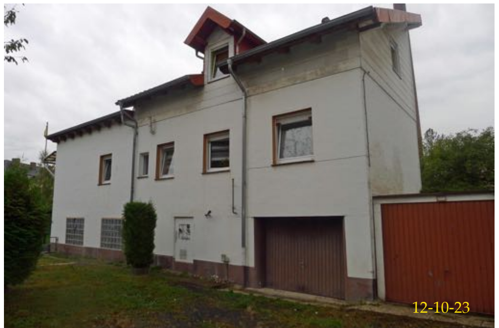
Hinterhaus Ansicht von Osten
