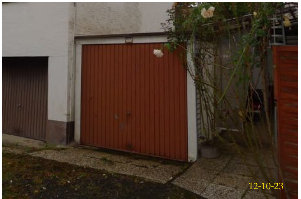
Blechgarage 1 Ansicht von Osten
