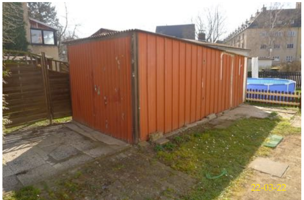
Blechgarage 2 Ansicht von Norden
