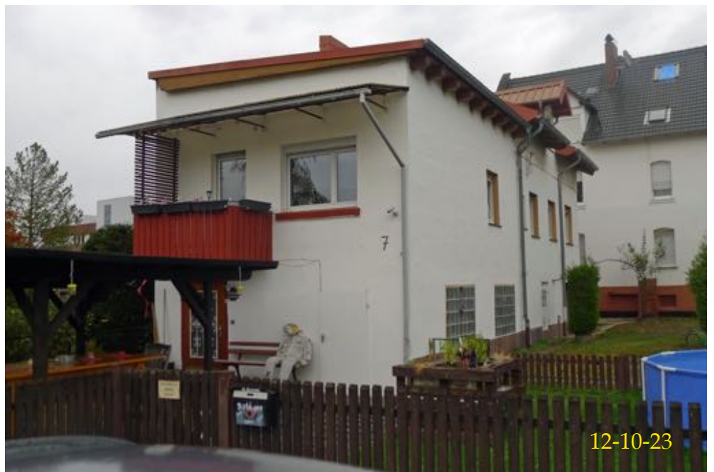
Hinterhaus Ansicht von Süd-Westen
