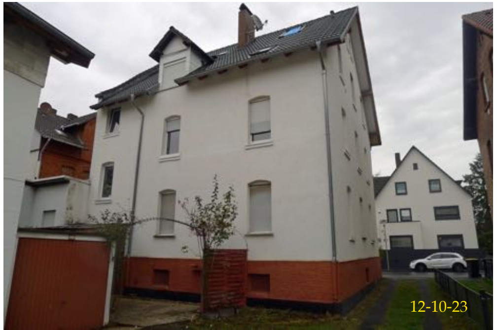
Vorderhaus Hofansicht von Süd-Westen
