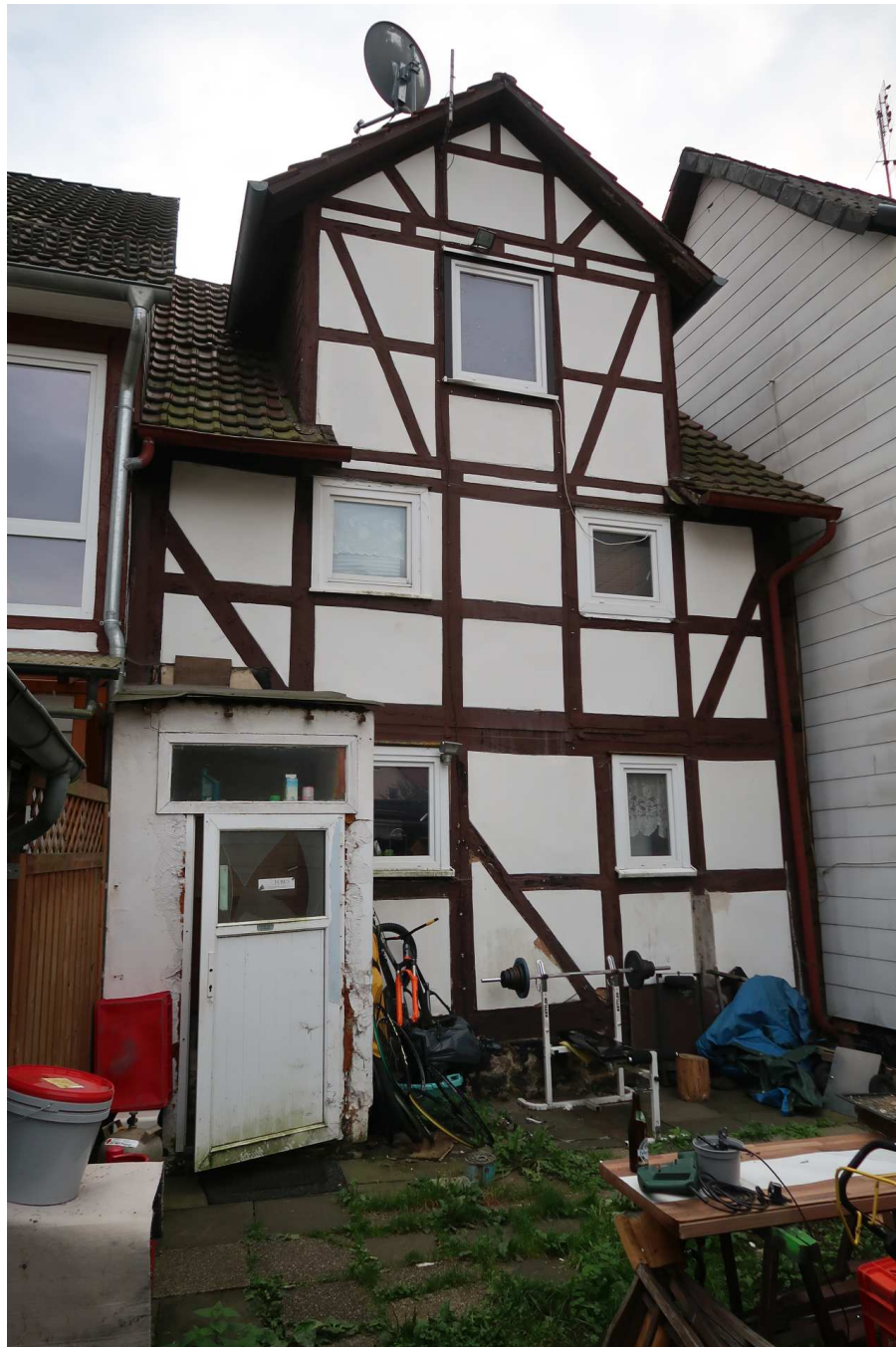
Bild 2, Einfamilienwohnhaus Alte Berliner Straße 15 in Helsa, rückseitige, nördliche Ansicht
