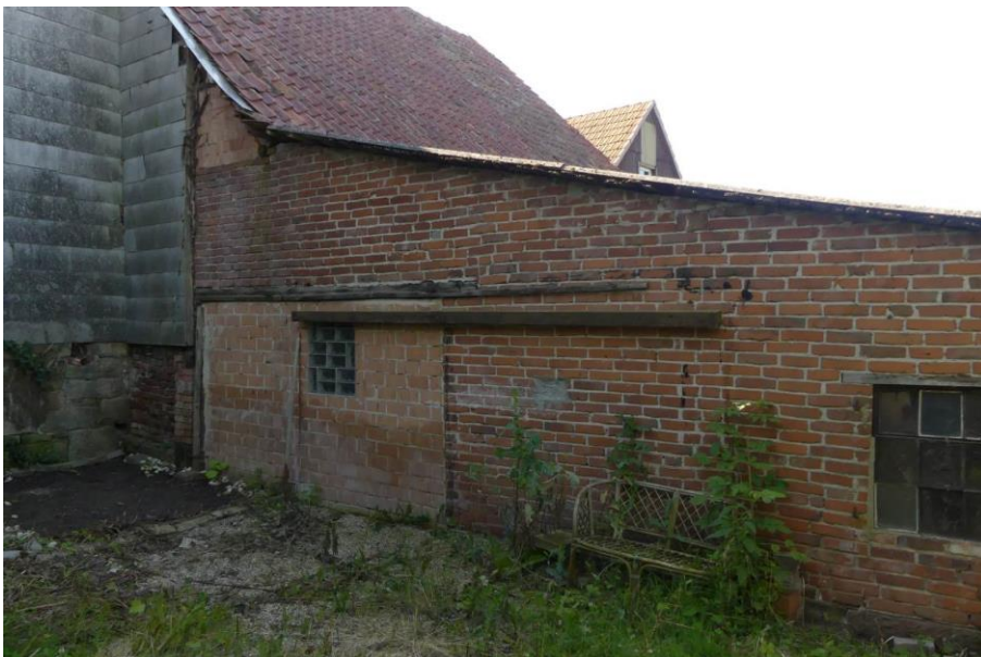
Nordansicht – Angeschleppter Anbau
