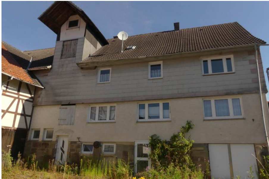
Süd – Hofansicht Wohnhaus
