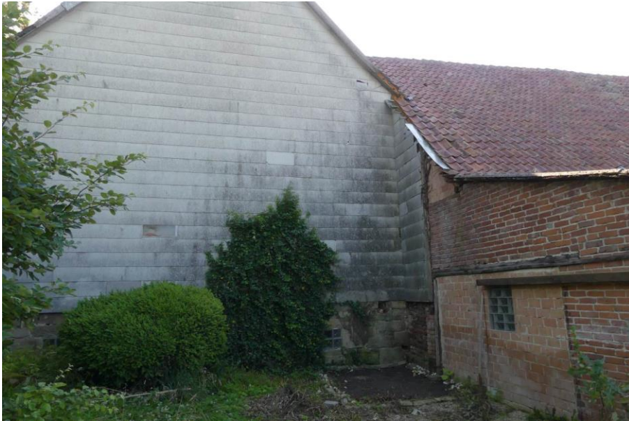
West – Giebelseite Wirtschaftsgebäude
