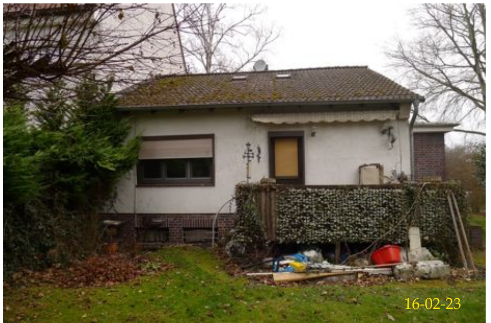
Gartenansicht von Süd-Osten
