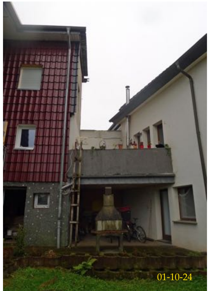
Ansicht Verbindungsbauteil zwischen Vorder- und Hinterhaus von Norden
