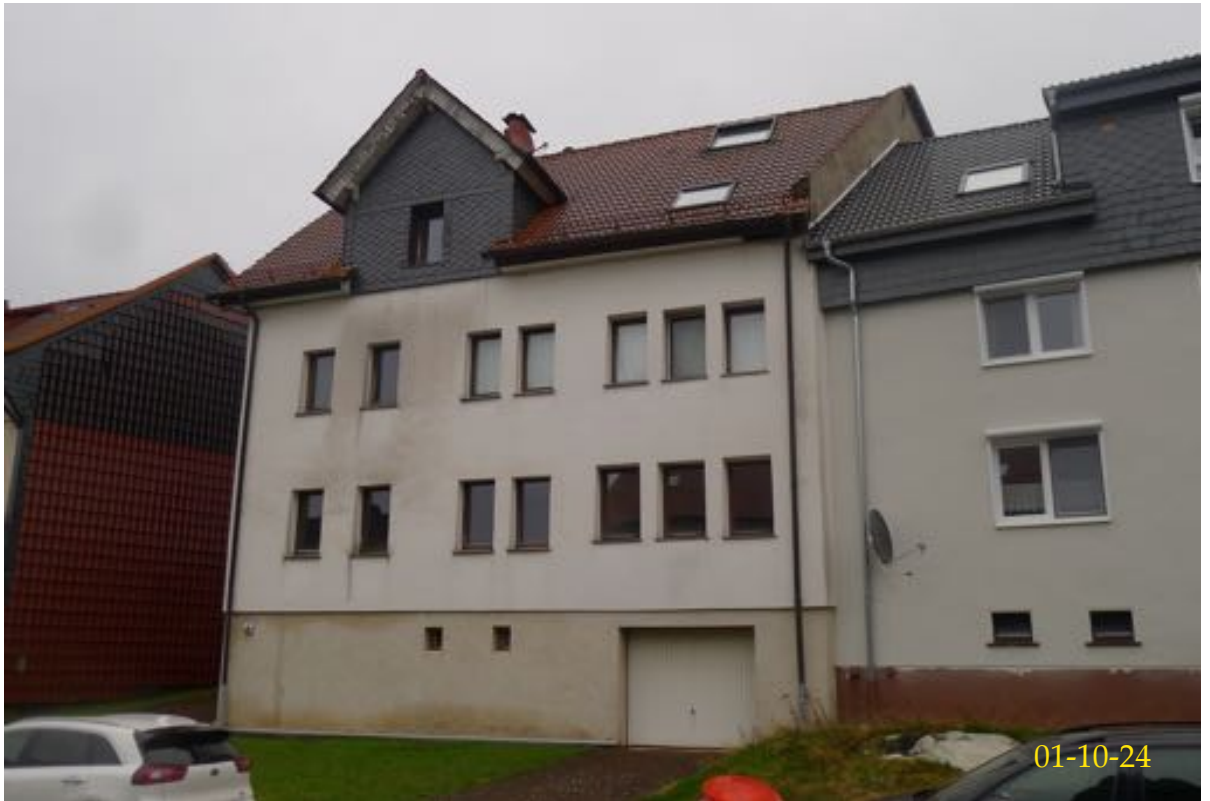
Vorderhaus Straßenansicht von Süd-Westen
