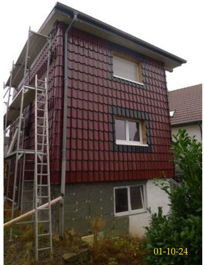
Hinterhaus Ansicht von Norden
