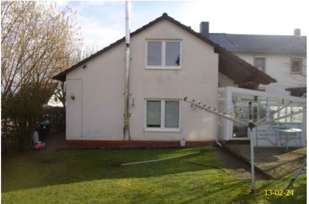
Anbau Ansicht von Westen
