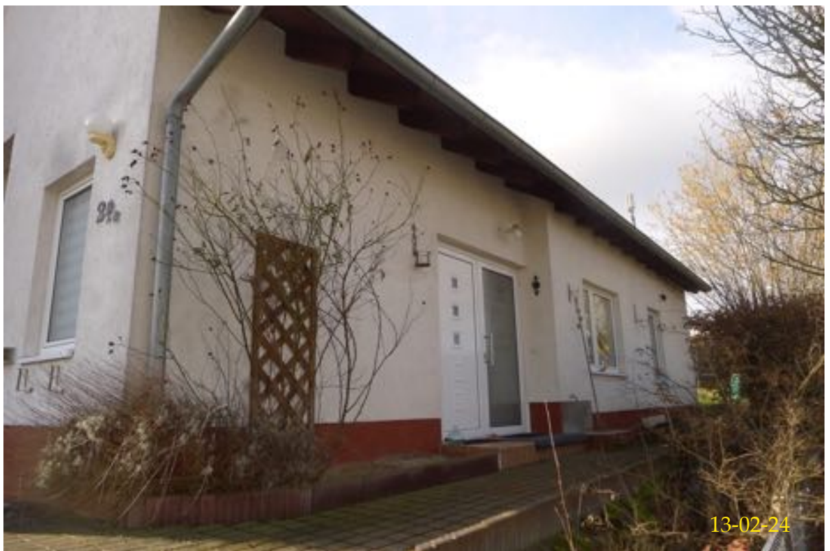
Anbau Ansicht von Nord-Osten
