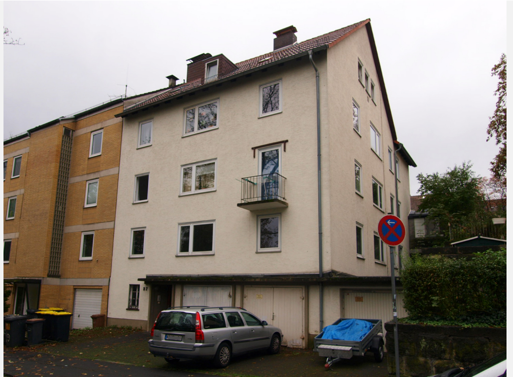
Ansicht des Mehr- familienhauses von der Tannenstraße (Nord-Westen)
