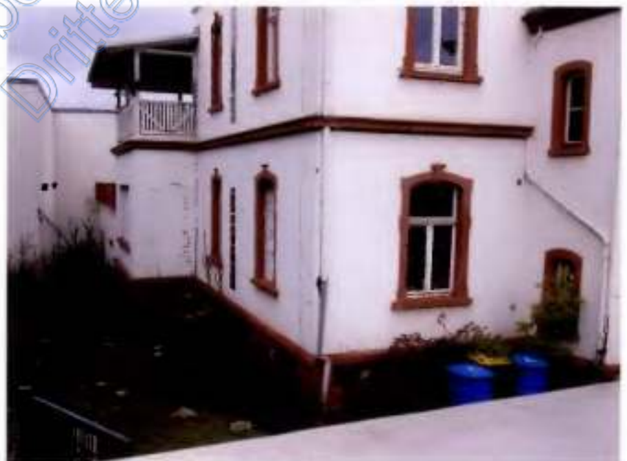
Ansicht südwestlicher Grundstücksbereich von dem Parkplatz des Nachbargrundstücks (Süd-Osten)
