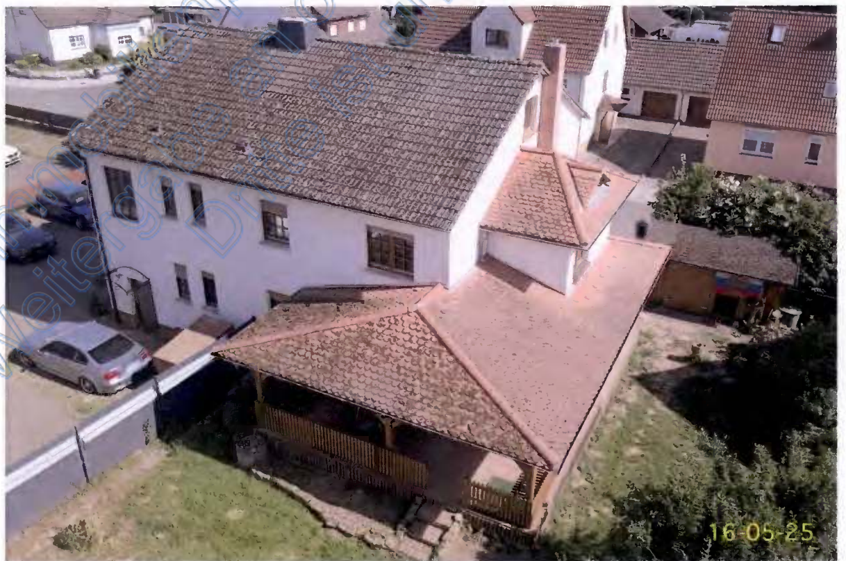
Dachdeckung von Norden
