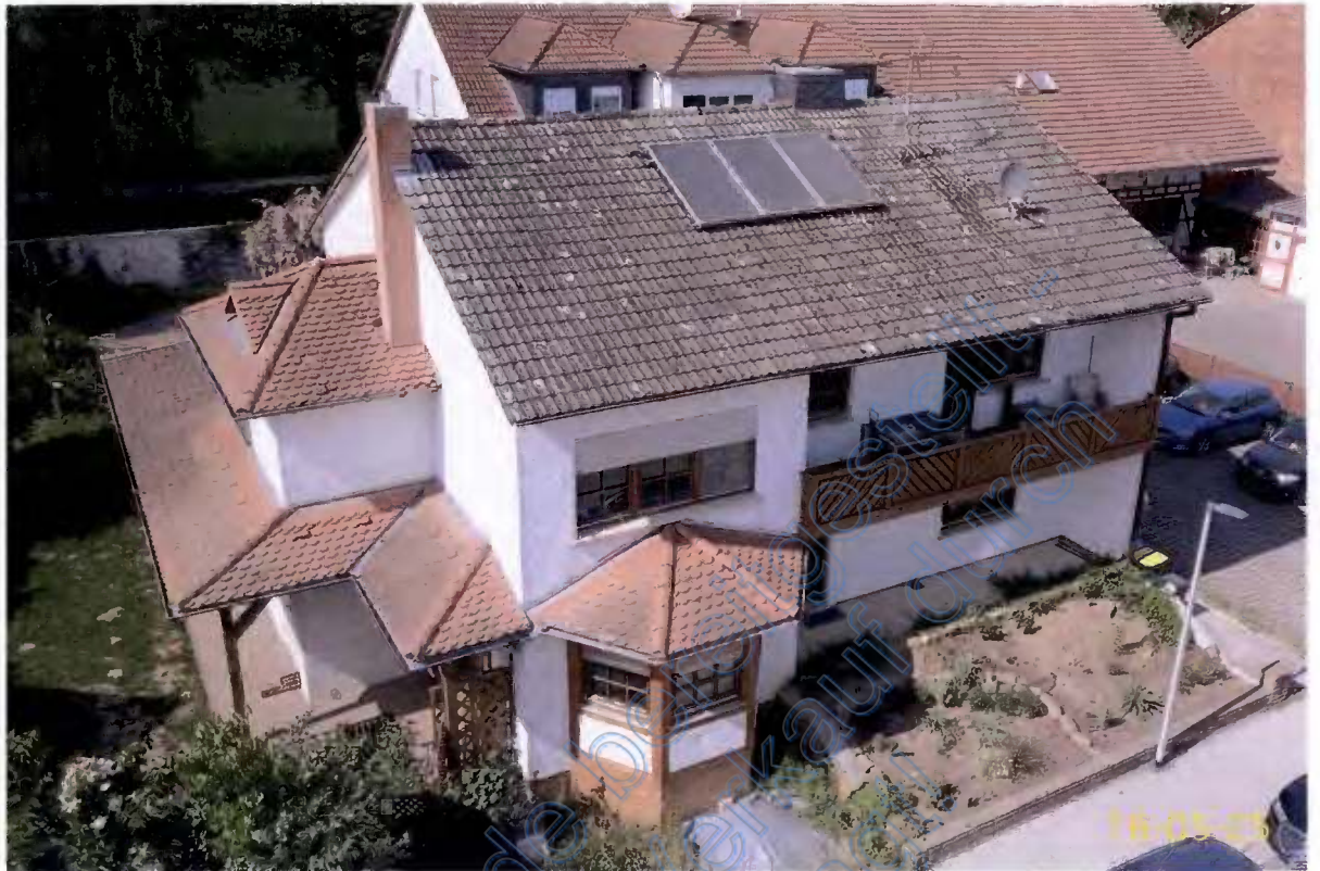
Dachdeckung von Süden
