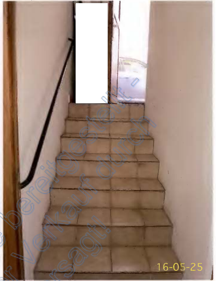
Treppe zum Kellergeschoss
