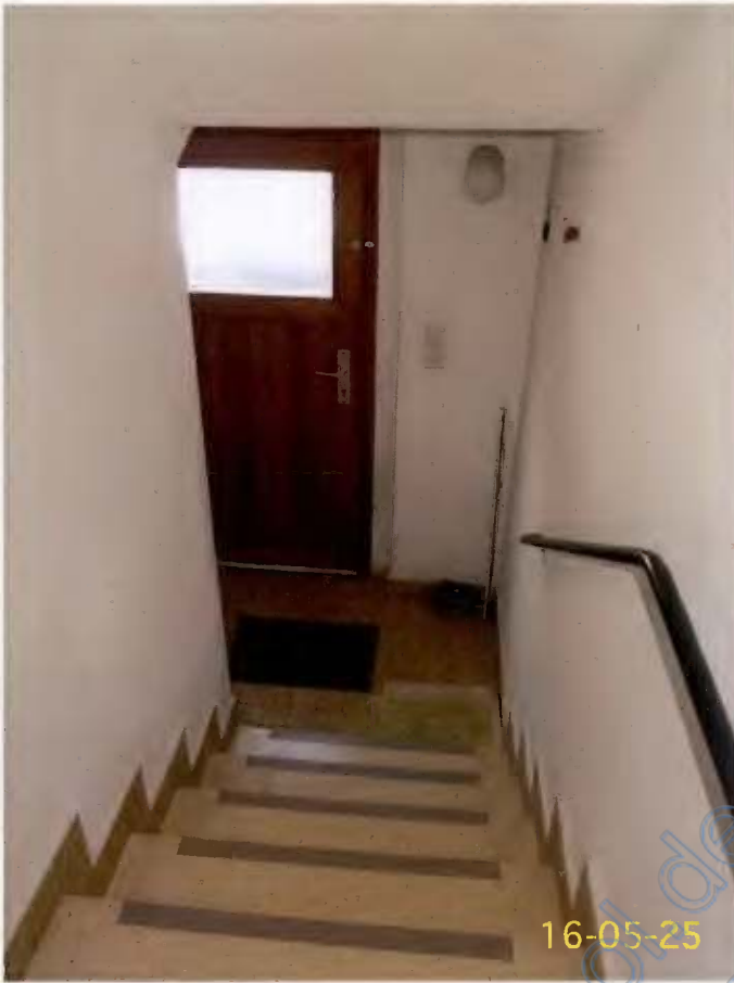
Treppe zum Kellergeschoss
