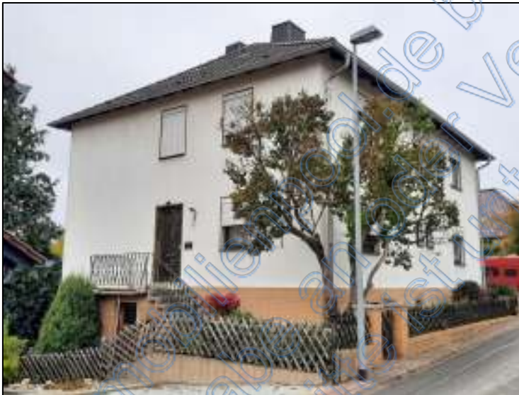
Abb. 2: Giebelseite und Straßenfassade
