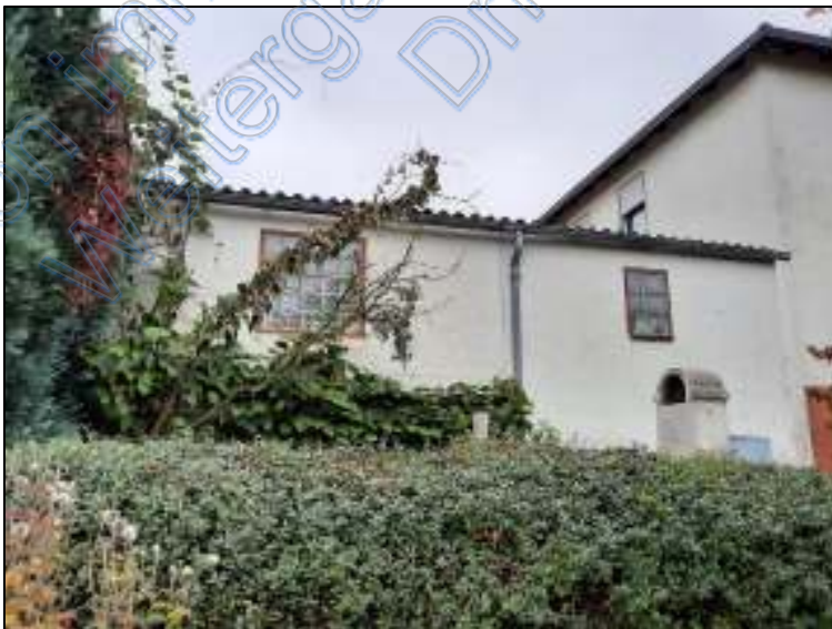
Abb. 18: Flurstück 65/1 mit Garagen, Rückansicht Garagen
