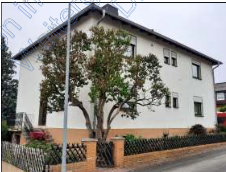
Abb. 3: Giebelseite und Straßenfassade
