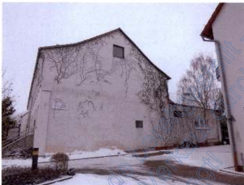
Foto 7 Ost – Giebelseite Geb. Teil 1
