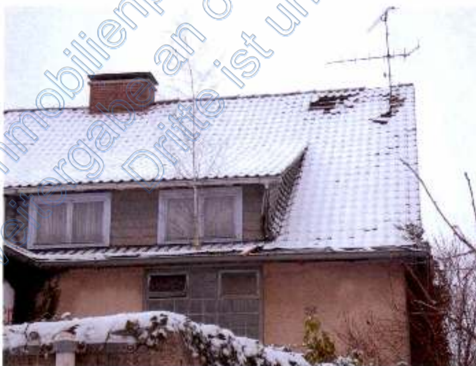
Foto 12 Nord – Dachfläche Geb. Teil 2
