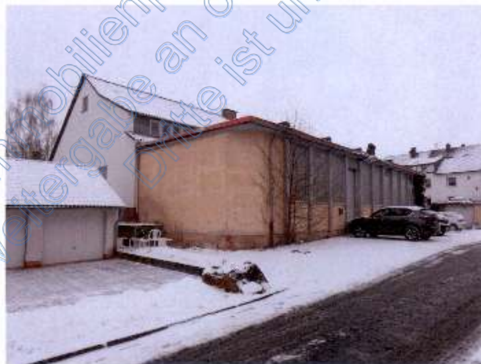
Foto 10 Nord - Ostansicht Geb. Teil 3 - Bahnhofstraße
