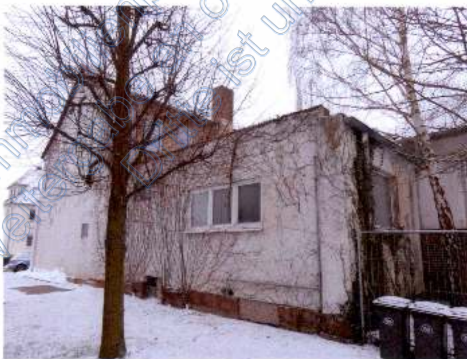
Foto 8 Nord – Ostansicht Geb. Teil 1
