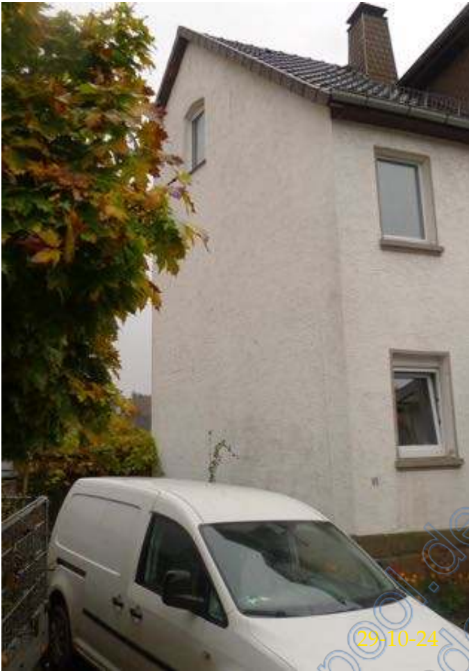
Giebelwand von Nord-Osten
