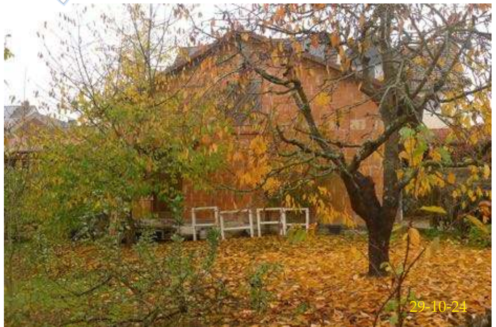
Doppelgarage Giebelwand von Süden
