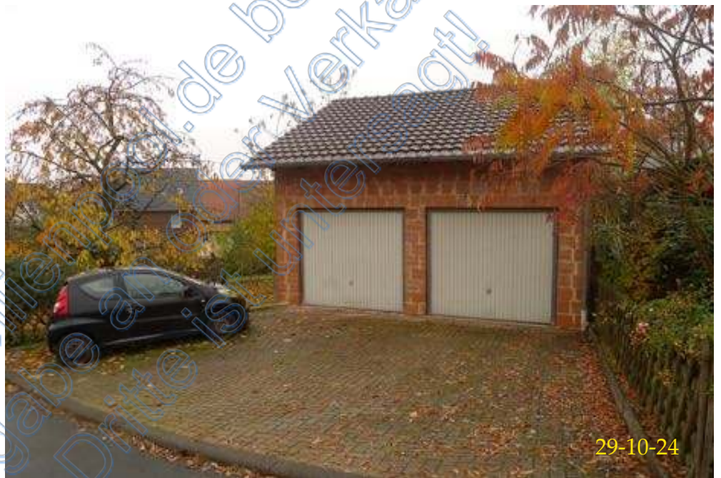
Doppelgarage Straßenansicht von Osten
