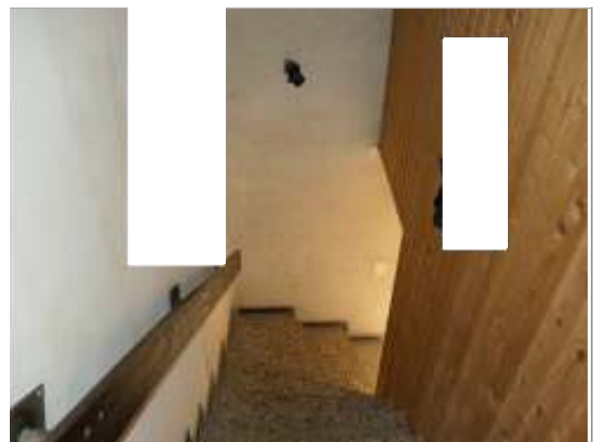
Bild 30: Treppe Erdgeschoss / Hanggeschoss
