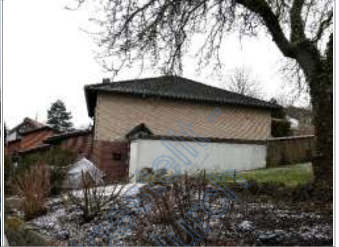
Bild 2: Ansicht von Osten
