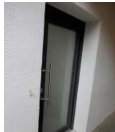
Bild 6: Eingang zum Hanggeschoss (westlich)
