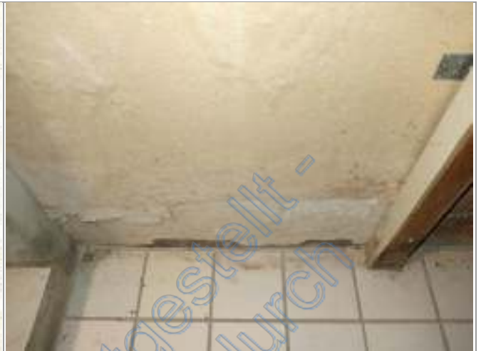
Bild 32: Hanggeschoss (Kellerbereich) | Wanddetail
