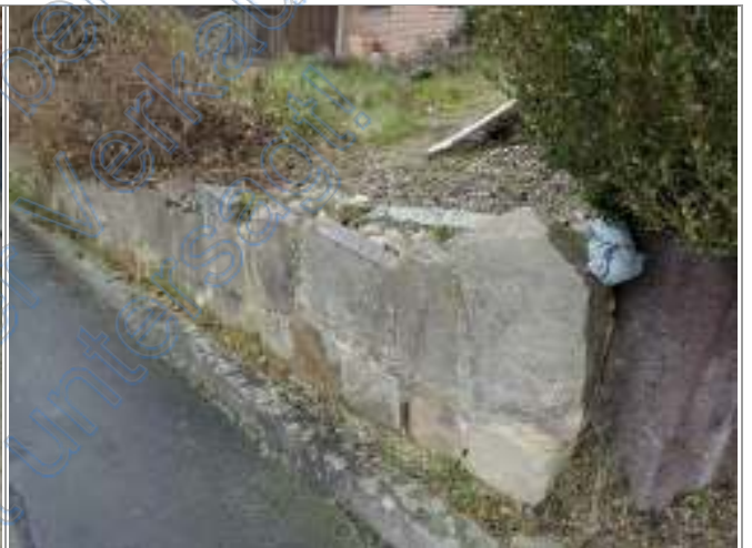
Bild 40: Hangabfangung zu Straße
