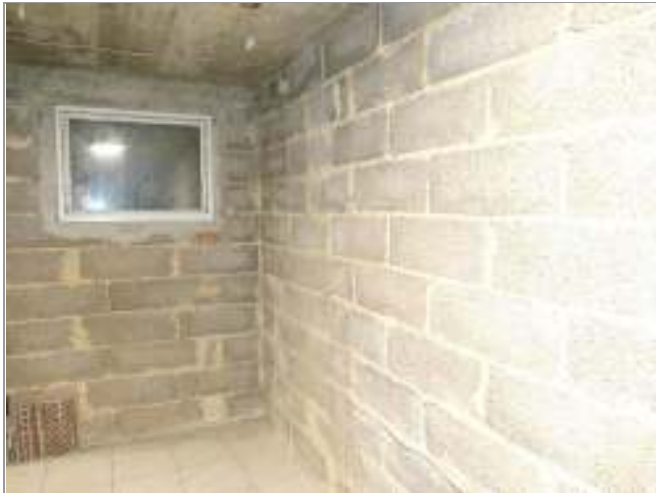
Bild 31: Hanggeschoss (Kellerbereich) | Abstellraum
