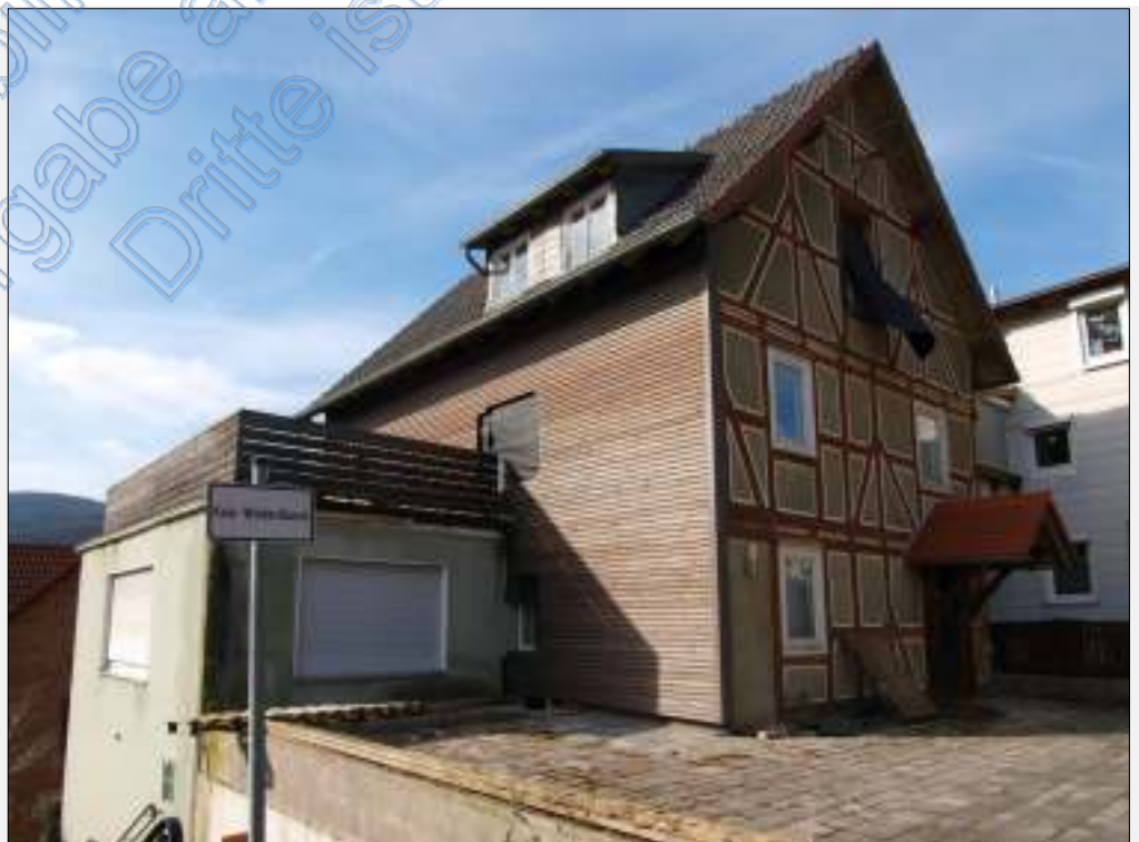
Ansicht des Zwei- familienhauses mit Anbau und Kellererweiterung „Bergstraße 11“ von Süd-Osten
