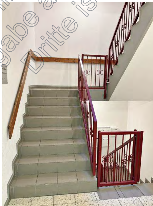
Foto Nr. 4 Treppenhaus EG
