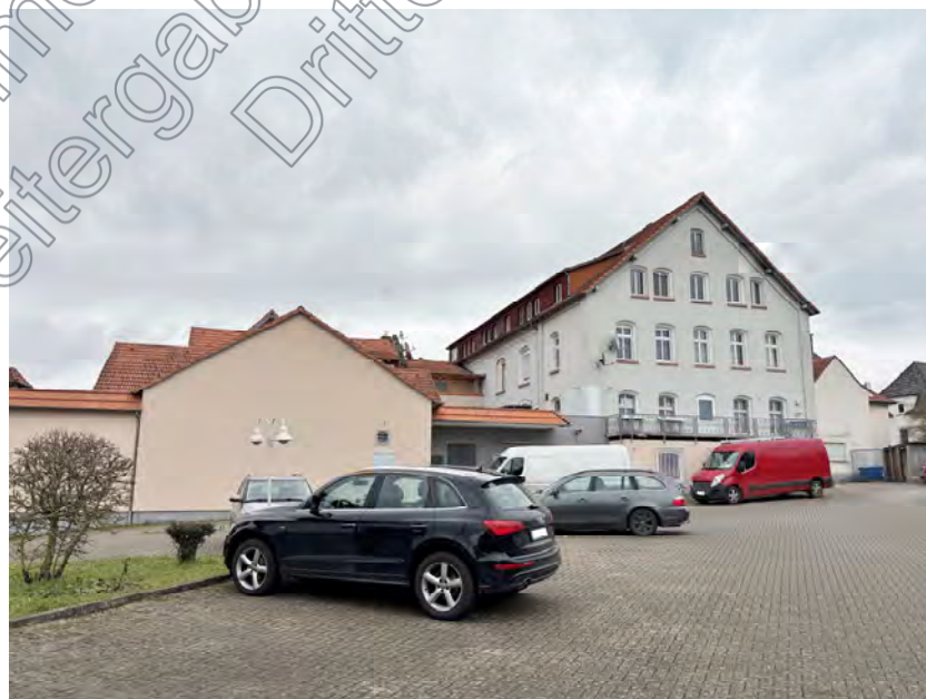
Foto Nr. 2 Südwestansicht Gebäude Nr. 24+26
