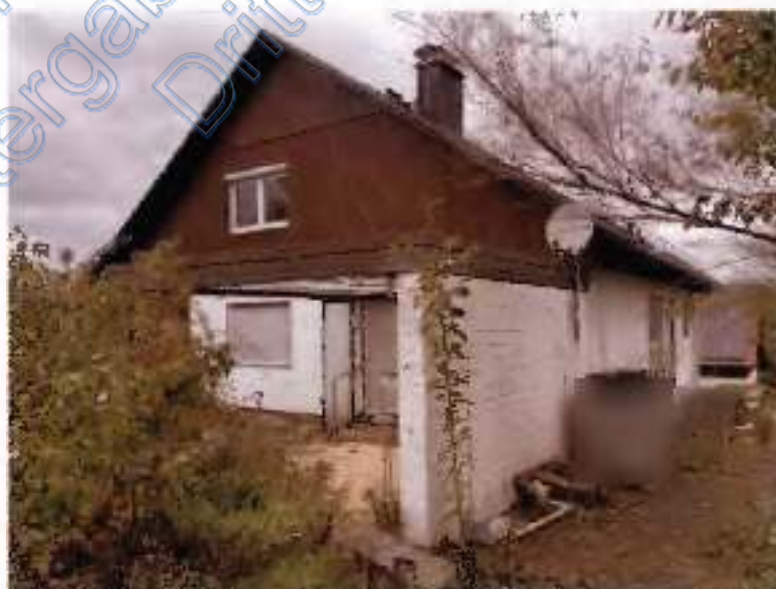
Foto Nr. 2 Südostansicht Wohnhaus
