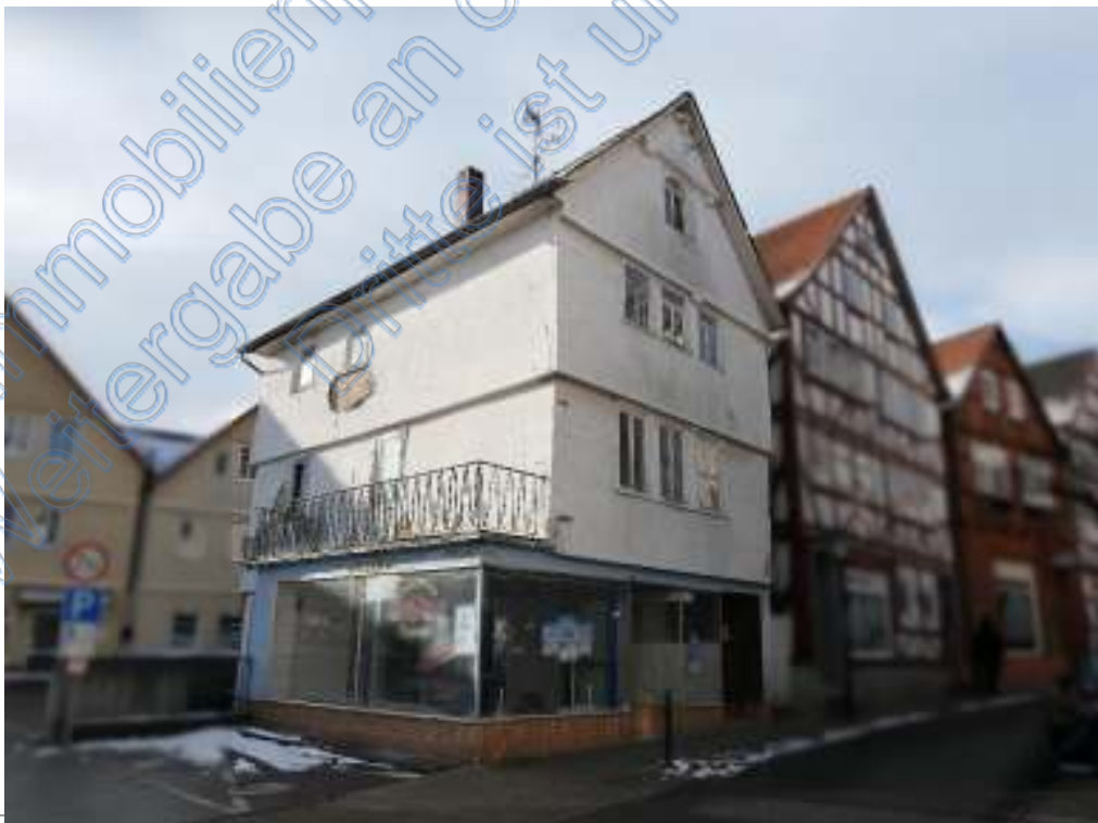
Bild 4: Ansicht von Nordosten I aus Sicht der Straße Untergasse
