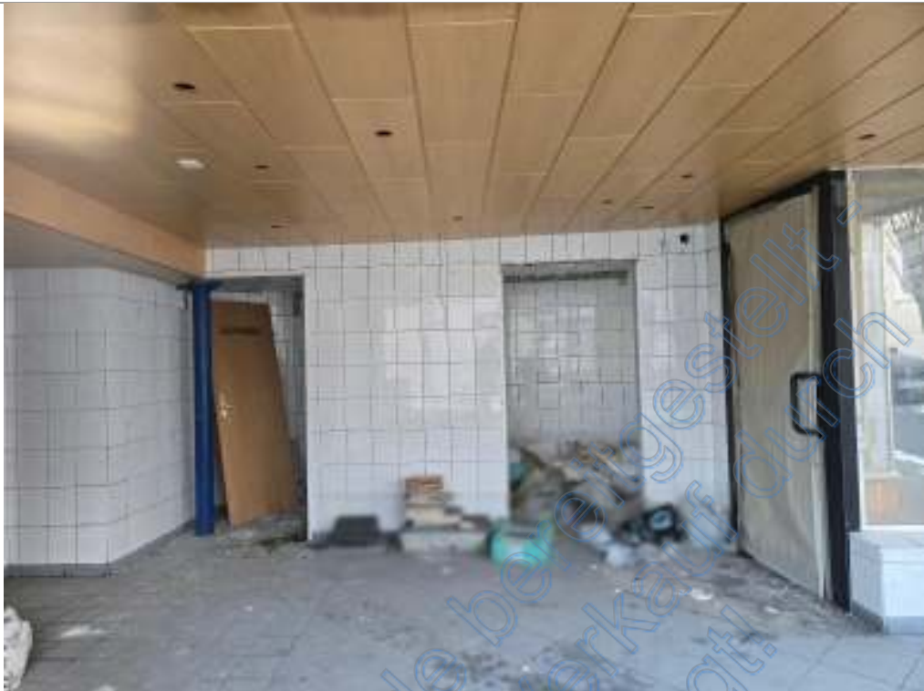
Bild 9: Blick in den Laden | von Osten
