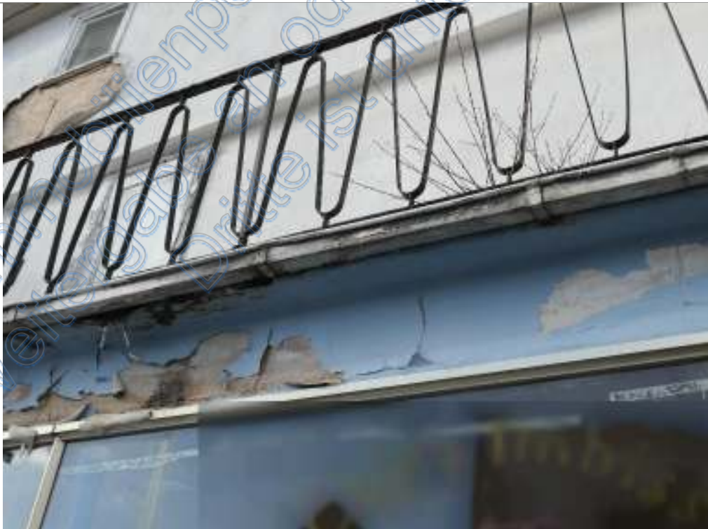
Bild 20: Detail Ostfassade / Balkon
