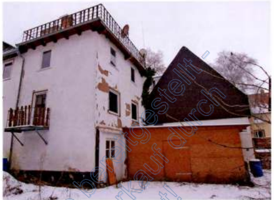
Ansicht des Mehrfamilienhauses und des Anbaus in Holzkonstruktion von Osten
