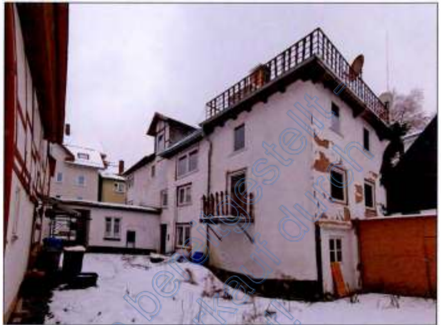
Ansicht des Mehrfamilienhauses vom Innenhof (Nord-Osten)
