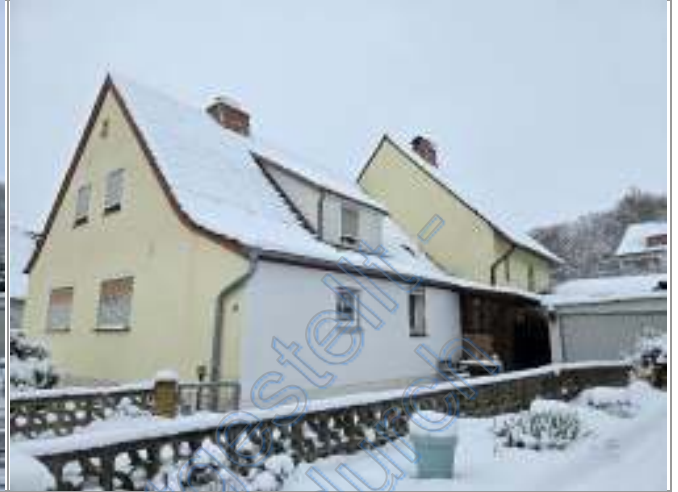
Bild 2: Ansicht von Nordosten
