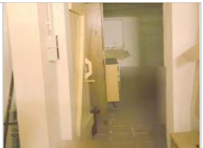
Bild 12: Bj. 1946 / KG | Flur und Kellerraum 1
