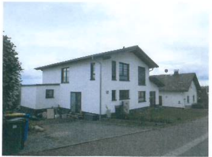
Straßenansicht von Nordwesten
