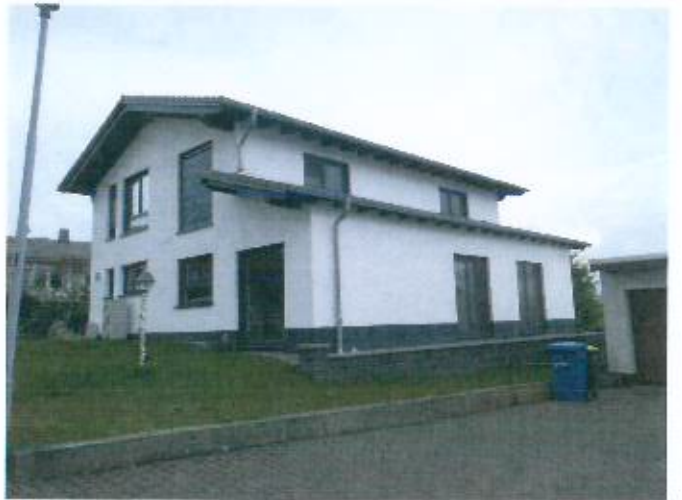
Straßenansicht von Südwesten
