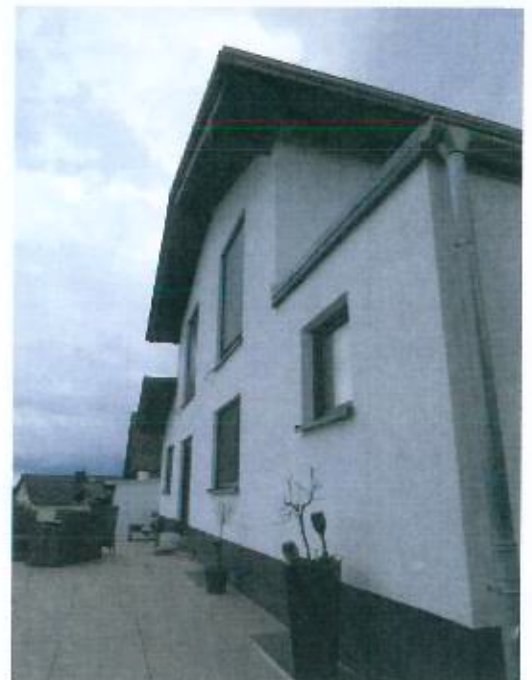
Ansicht von Norden
