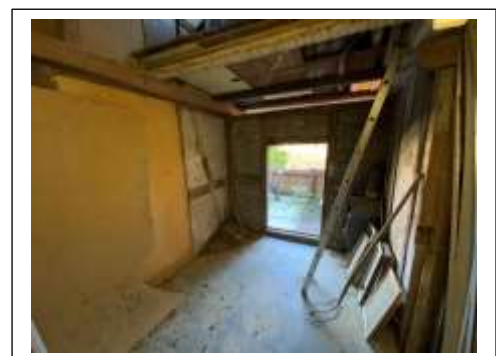
ehem. Stall (3.2) -Obergeschoss-
