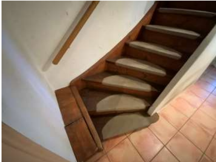
Bild 22: Treppe EG – OG (1)
