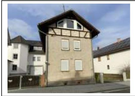
Das Satteldach hat eine Betonziegeleindeckung. Es handelt sich dabei nicht um die ursprüngliche Eindeckung des Objektes. Die Außenfassade des Objektes hat einen mineralischen Außenputz, ohne Dämmung. Im Bereich der nachträglichen Aufstockung sind die Wände unverputzt. Hier ist eine Holzkonstruktion mit ausgemauerten Gefachen sichtbar.
