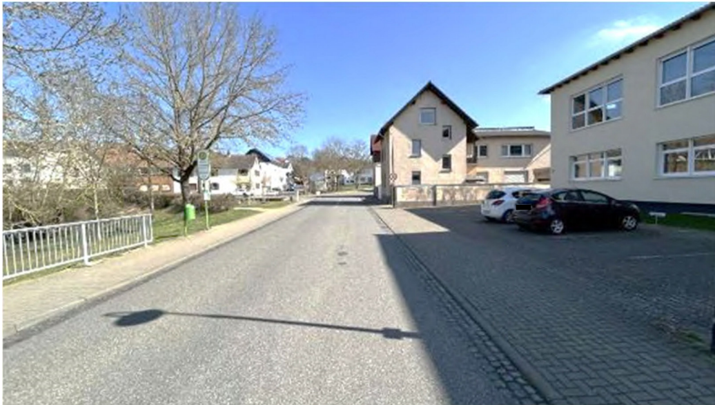
Bild A1 Blick in die Erschließungsstraße
