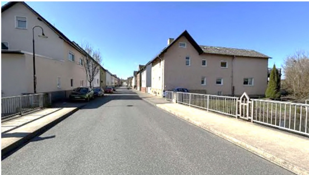
Bild A2 Blick in die Erschließungsstraße
