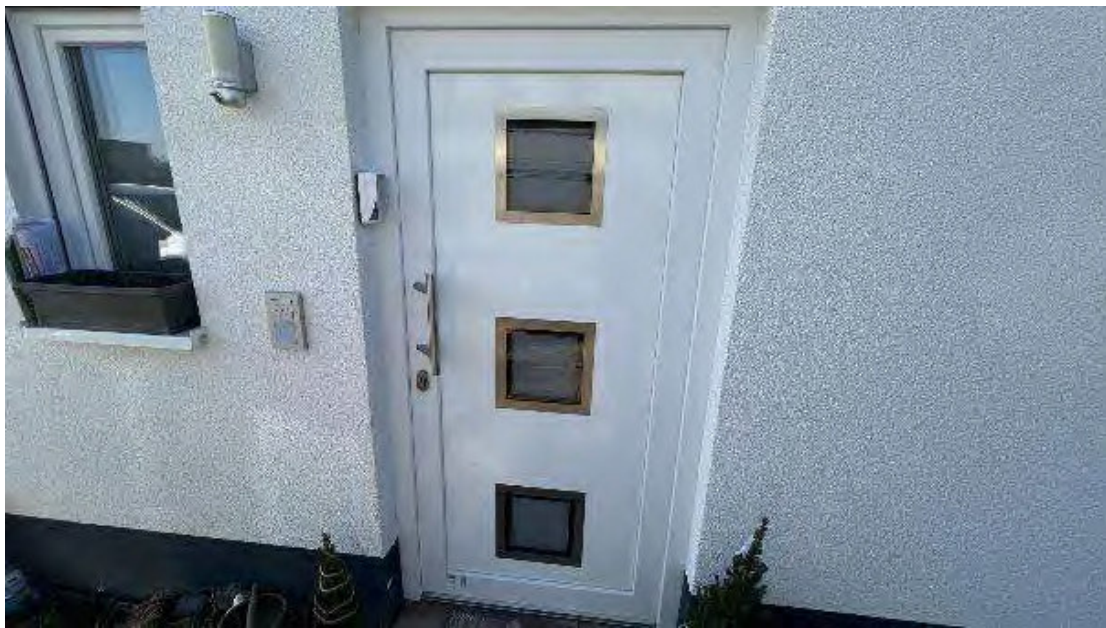
Bild B3 Hauseingang
