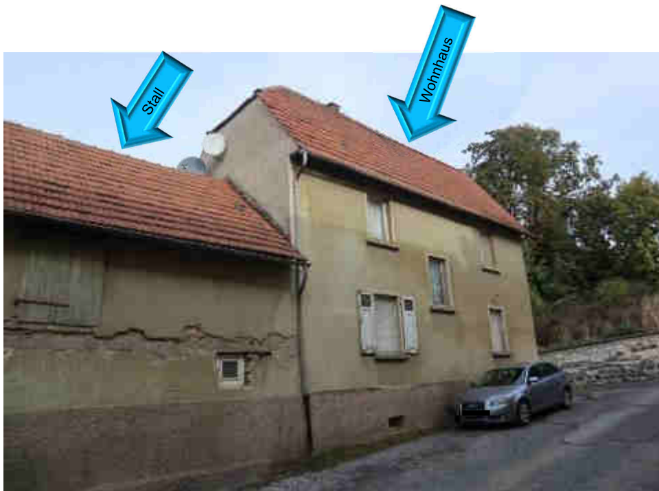
Bild B5 Südostfassade
