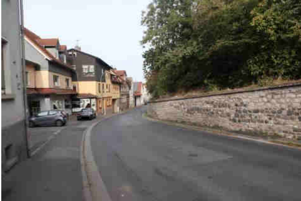
Bild A1 Blick in die Erschließungsstraße
