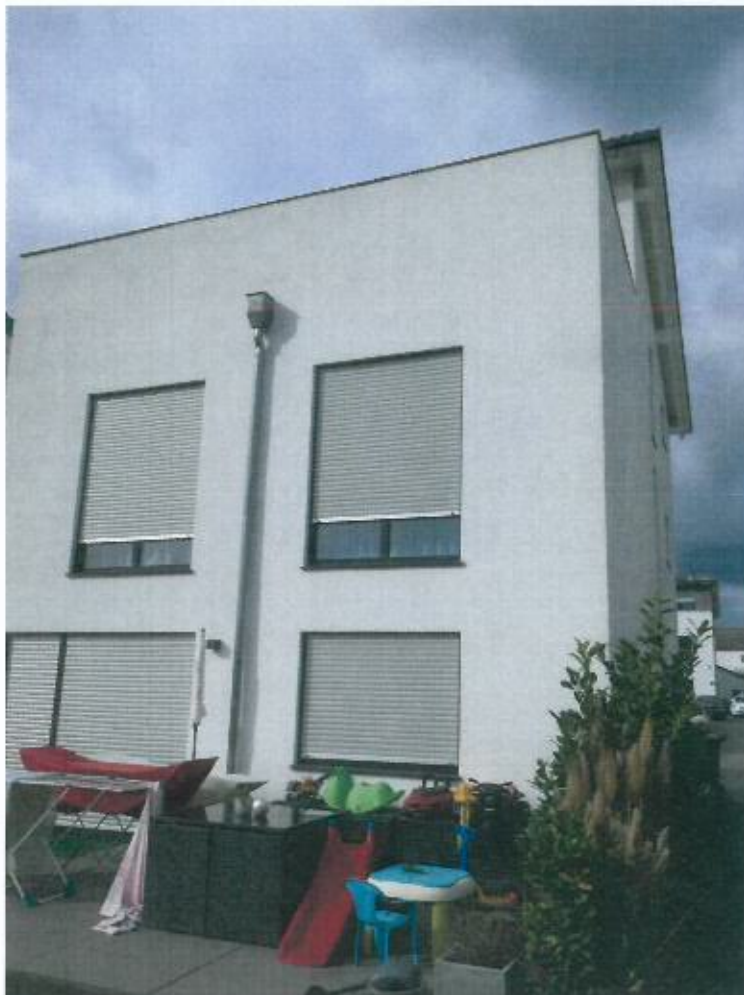
Bild 4, Gartenansicht von Südosten
