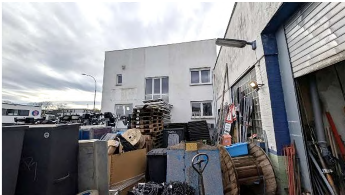
Bild B4 Bürogebäude
