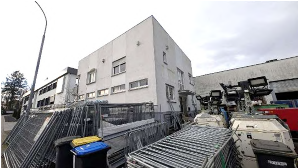
Bild B5 Bürogebäude
