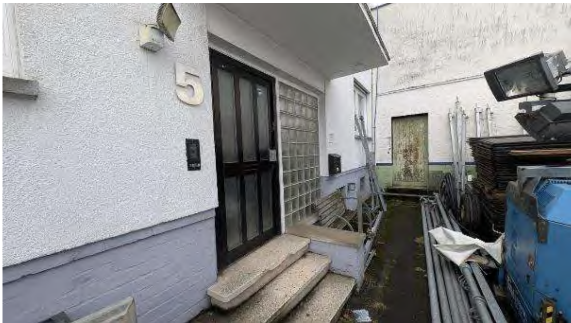
Bild B8 Eingang Bürogebäude
