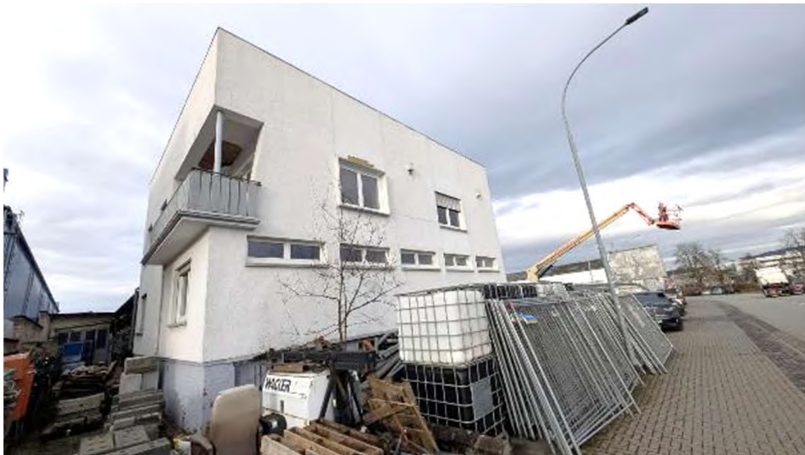
Bild B6 Bürogebäude
