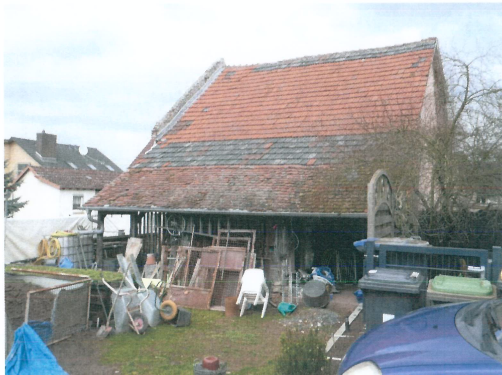
Ansicht von Südwesten (Die Scheune befindet sich auf dem Nachbargrundstück)
